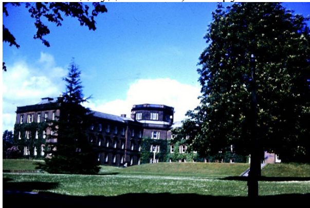
Крайтон Холл: Главное здание клиники
